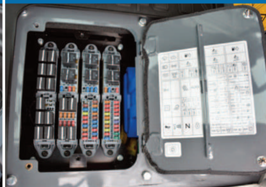
Quadro fusibili sotto al piano cabina
